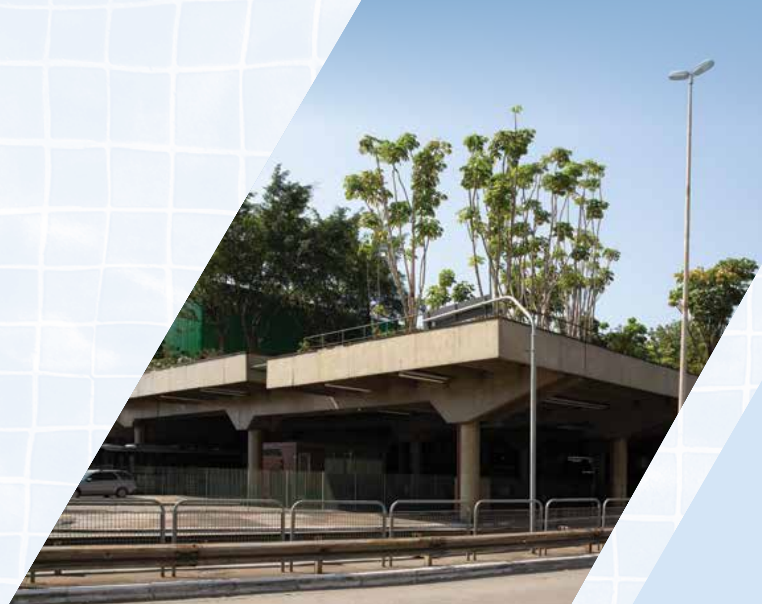
Terminal e estação Palmeiras - Barra Funda
